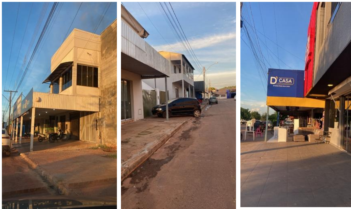
Figura 2.23: Calçadas obstruídas com edificações e veículos.
