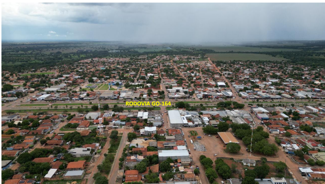
Figura 2.5: Malha urbana de Nova Crixás (sede) vista de leste a oeste. Com destaque à Rodovia GO-164 que corta a malha urbana no sentido norte-sul.
