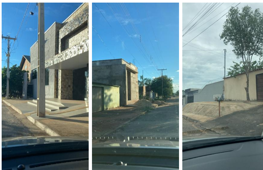
Figura 2.15: Obstrução da calçada.
