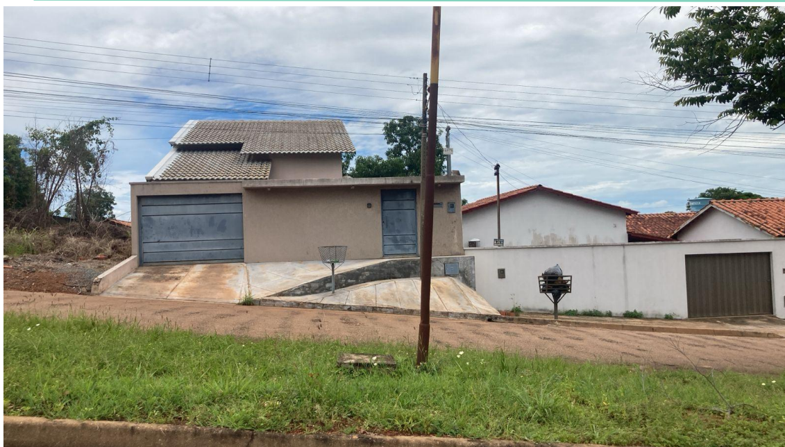
Figura 2.14: Obstrução das calçadas.
